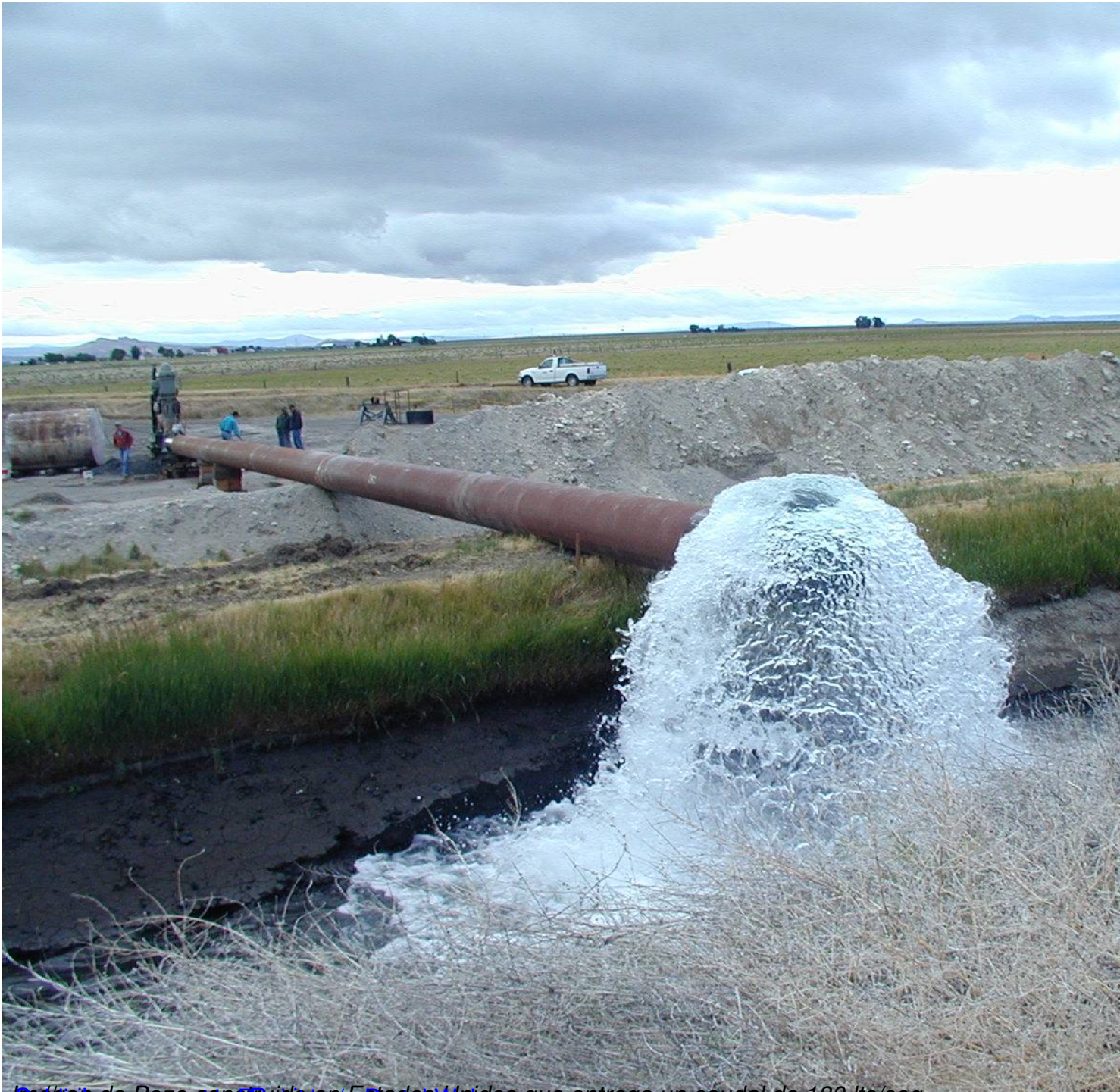
Burgos, Pozos Constructos en Estados Unidos que entrega un caudal de 180 lts/seg.
